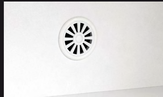
Wywietrzniki w szafkach dolnych.
